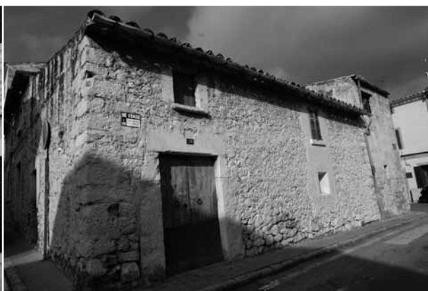
Fig. 7. Casa urbana, C/ Coves, 109 (Inca)
