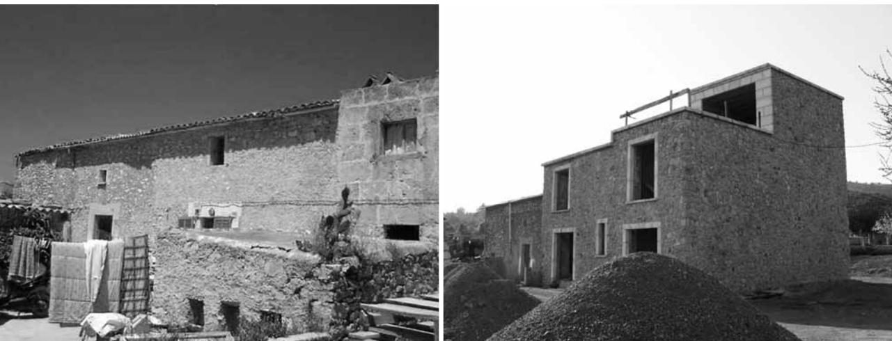
Fig. 5. Imatge d'abans i després de les obres en un bé catalogat a Son Servera, realitzades amb una llicència de canvi de coberta.
