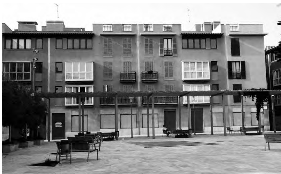
Fig. 7. Obra nova. Àmbit de Pla especial de sa Gerreria. Ficció pintoresquista en la substitució edificatòria.
