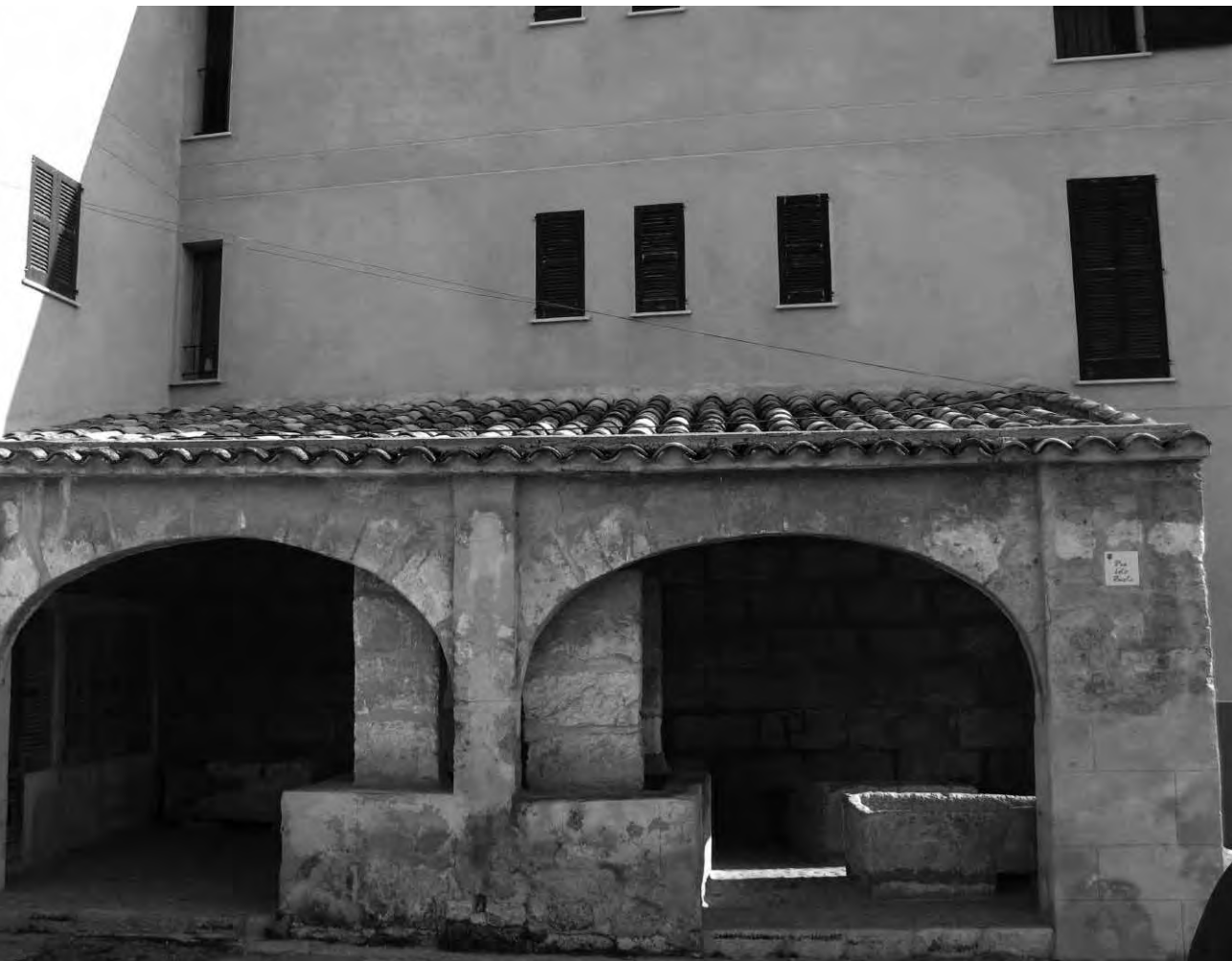
Fig. 2. Edifici de nova planta adossat a abeuradors tradicionals a Sineu
