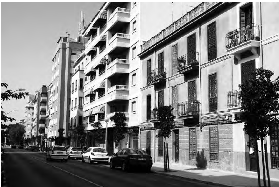
Fig. 9. Edificis de nova planta resultat de l'aplicació de la normativa del Pla General a la zona d'eixample extramurs. Contrast amb els edificis històrics que encara es mantenen
